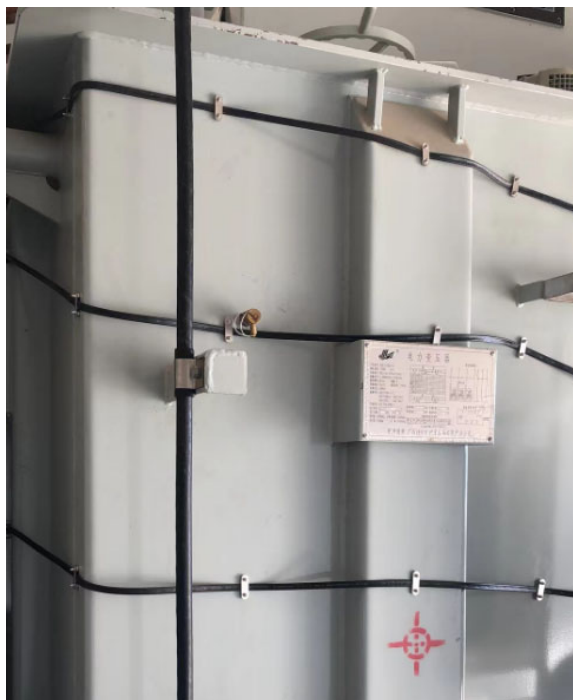
感温电缆变压器本体布置实例图
