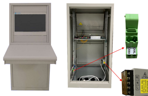
图 3-1-2 监控端接线示意图
